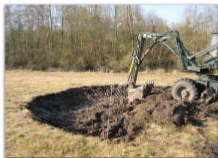
Chantier de creusement de mares
