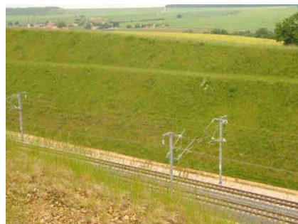
Déblai ensemencé d'un mélange de taxons locaux (Lavignévillie)
